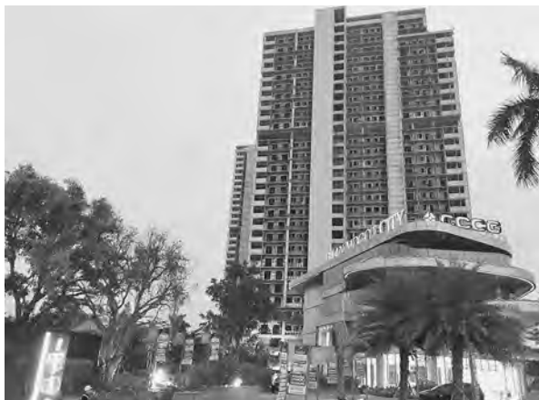
写真1 建設中の Daan Mogot City (表3 No.6)
