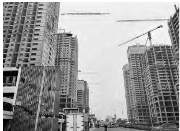
写真3 建設が進むメイカルタの第一街区
