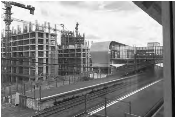
写真2 チサウック駅に隣接した Serpong Garden Apartment (建設中) (表3 No.7)
