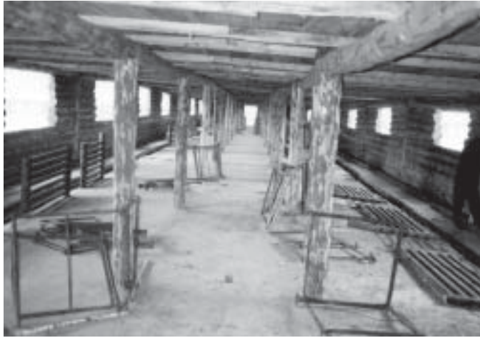
建設中の養豚ファーム
