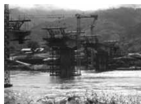
写真 2：第 4 メコン国際橋の工事
