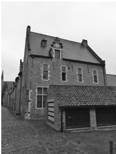
写真23 フラットNo.84のある建物
