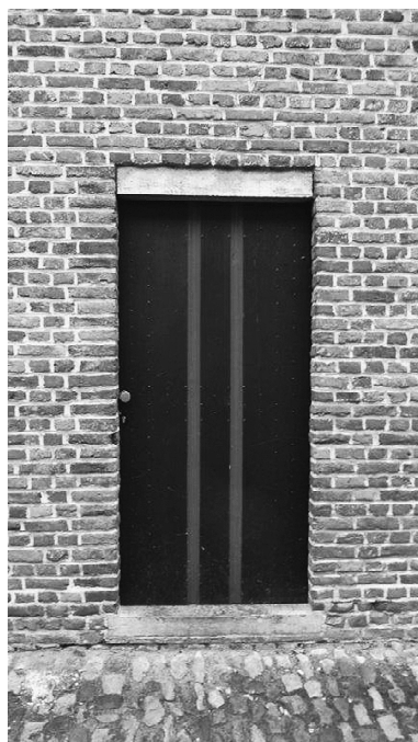
写真27 共同ランドリー入口
