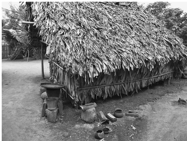
写真3 パルミラヤシの葉で屋根と壁を葺いたヤシ糖製造小屋
