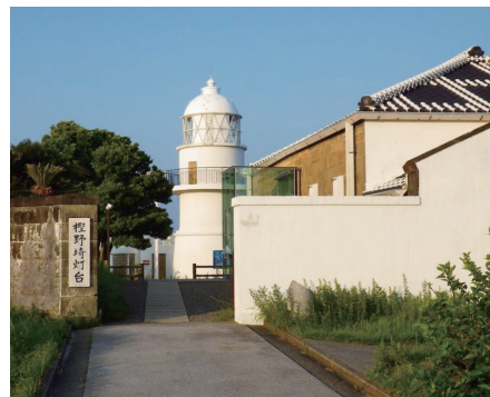
写真11：樫野崎灯台。件の難船の夜も海に光を送っていた。
